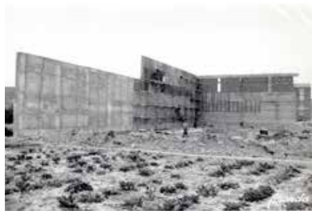
Construcción del nuevo frontón.
